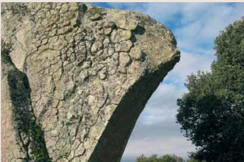
Figura 98.(I) Roturas o grietas poligonales en las proximidades de Berrocoto, Navas de San Antonio.
