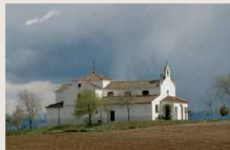
Figura 280. Ermita de la Virgen de la Aparecida, ubicada a media ladera de una loma de la campiña, en lugar de en su base, debido a la presencia de arcillas expansivas, con las que se vincula un milagro. (Foto: A. Carrera)
