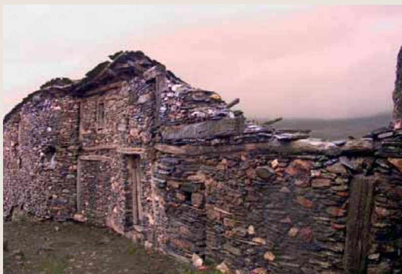
Figura 237. Ejemplo de arquitectura 'negra', El Muyo. (Foto: A. Carrera)
