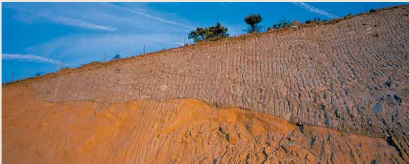
Figura 101. Cabalgamiento del basamento de granitos (grises, a la derecha) sobre unos sedimentos arenosos más recientes (tonos anaranjados, a la izquierda). El talud de la carretera no es perpendicular al trazado de la falla, de manera que éste aparece con una inclinación menor a la real. De igual manera que si vieras un corte en la vertiente de un tejado que no fuera hecho en el sentido de su máxima inclinación. (Foto: A. Carrera).
