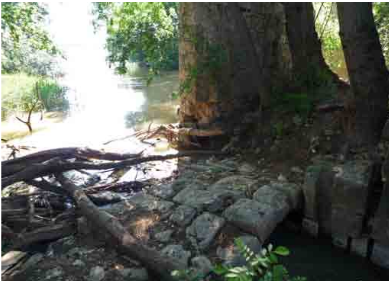
BÓVEDA DE PIEDRA SOBRE UNO DE LOS CANALES, ACEÑA DE OSLUGA. TORDESILLAS.
