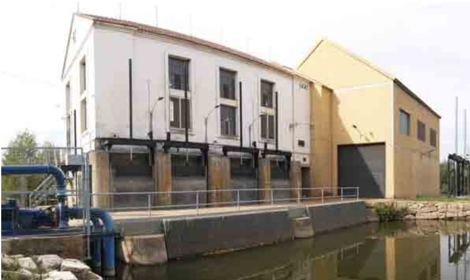
ENTORNO MINICENTRAL ELÉCTRICA DE LOS HERREROS, EN TORDESILLAS.
