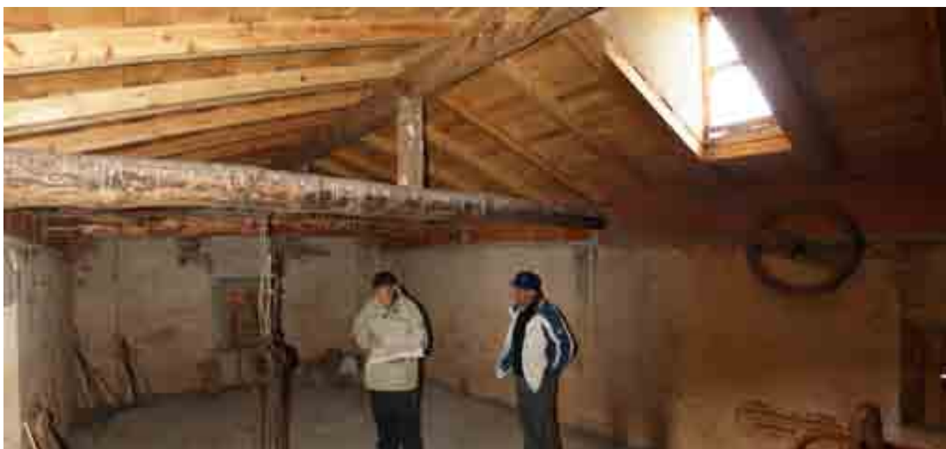
BAJOCUBIERTA CUBO RESTAURADO.
