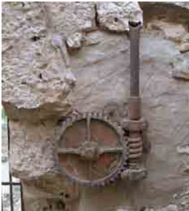
MECANISMO APERTURA COMPUERTA ALVIADERO.
