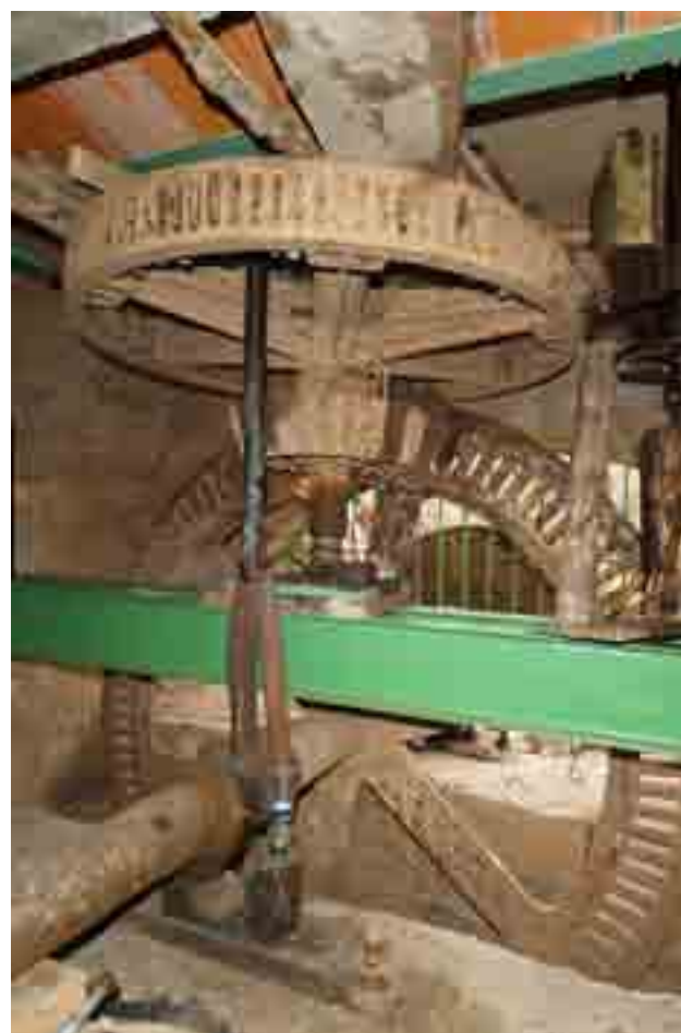
DETALLE ENGRANAJES DE LA PLANTA DEL CÁRCAVO.
