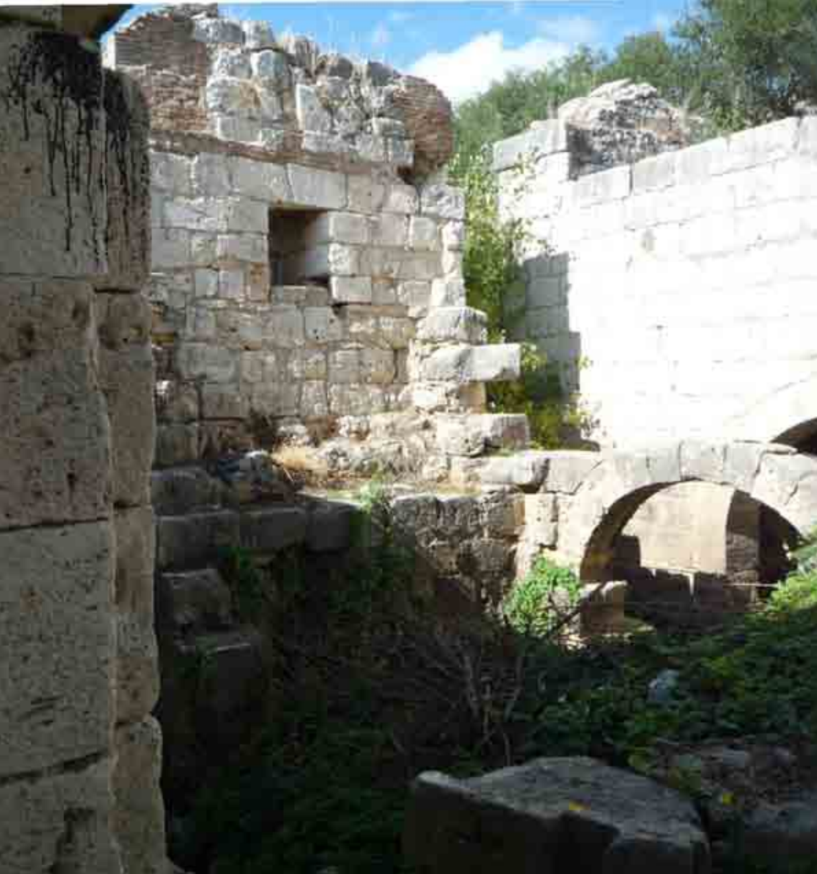
PANORÁMICA INTERIOR DE UNO DE LOS CUERPOS DE LA ACEÑA.
