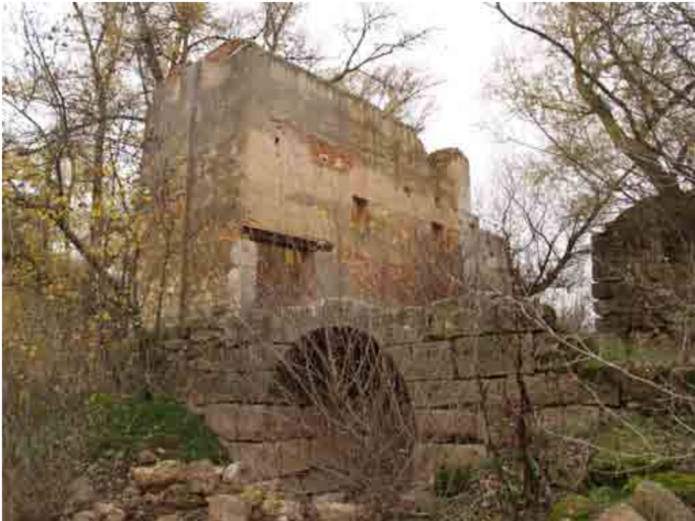
TAJAMAR DEL CUBO PRINCIPAL DE LA ACEÑA DE LA PERAL, EN TORO.
