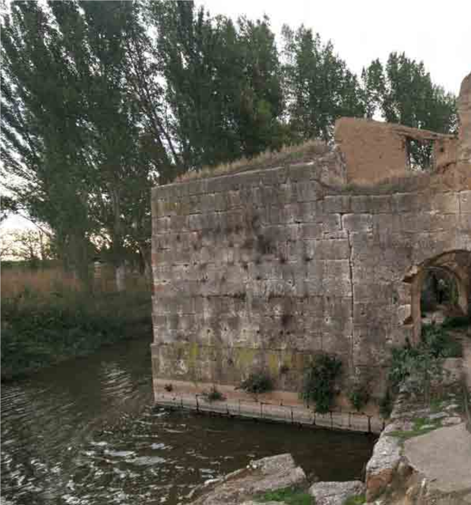
PUENTE ENTRE CUBOS 2 Y 3.
