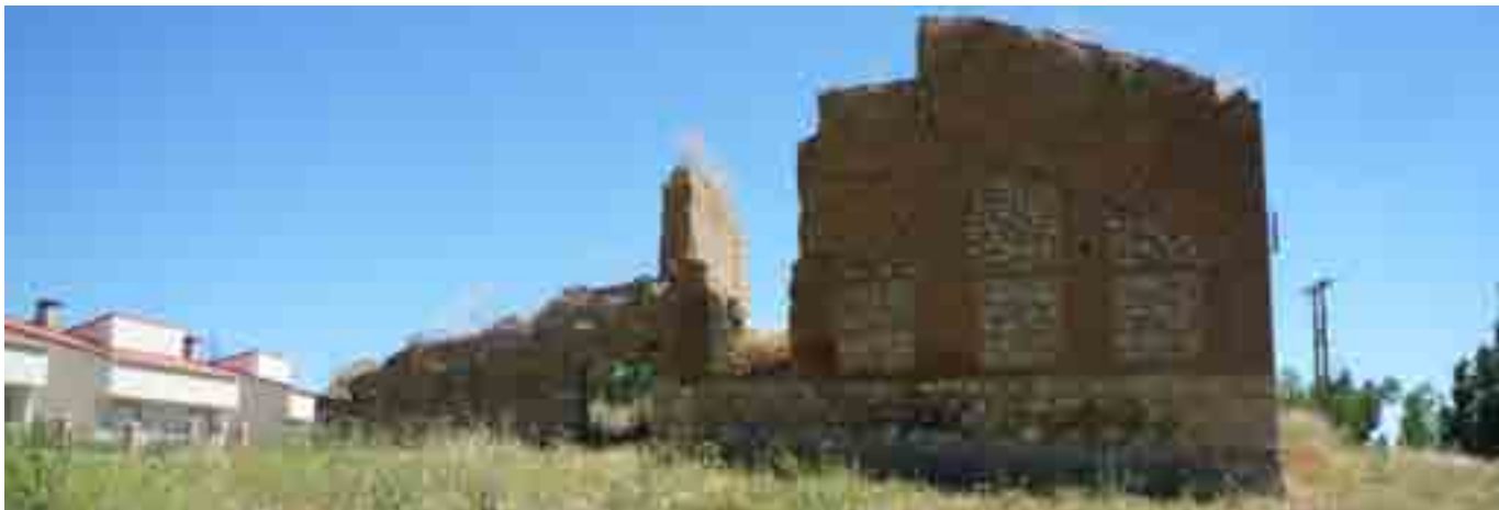
RESTOS VIVIENDA MOLINERO PRÓXIMOS A ACEÑA DE SAN MIGUEL DEL PINO.
