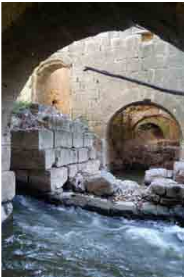
INTERIOR DEL CÁRCAVO.
