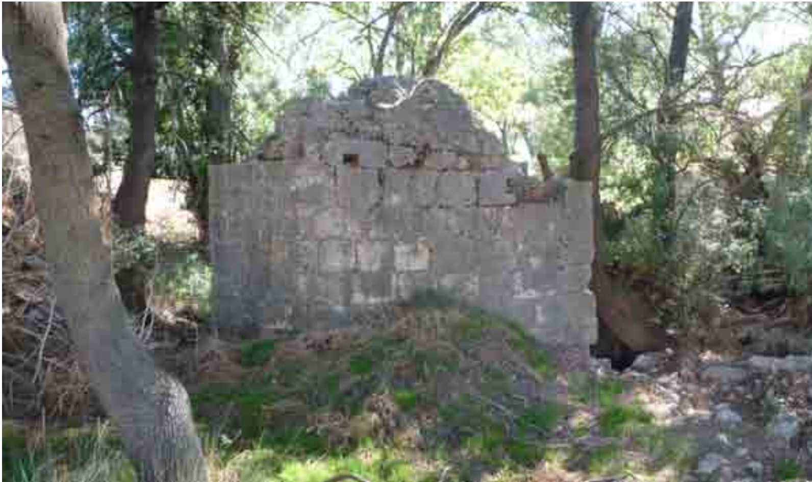
ENTORNO ACEÑA DE OSLUGA. TORDESILLAS.
