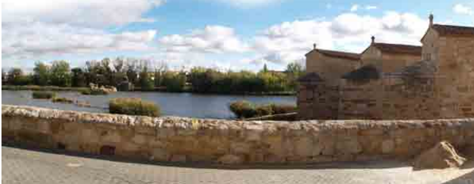
PANORÁMICA EXTERIOR AGUAS ARRIBA DE LA ACEÑA DE OLIVARES, EN ZAMORA.
