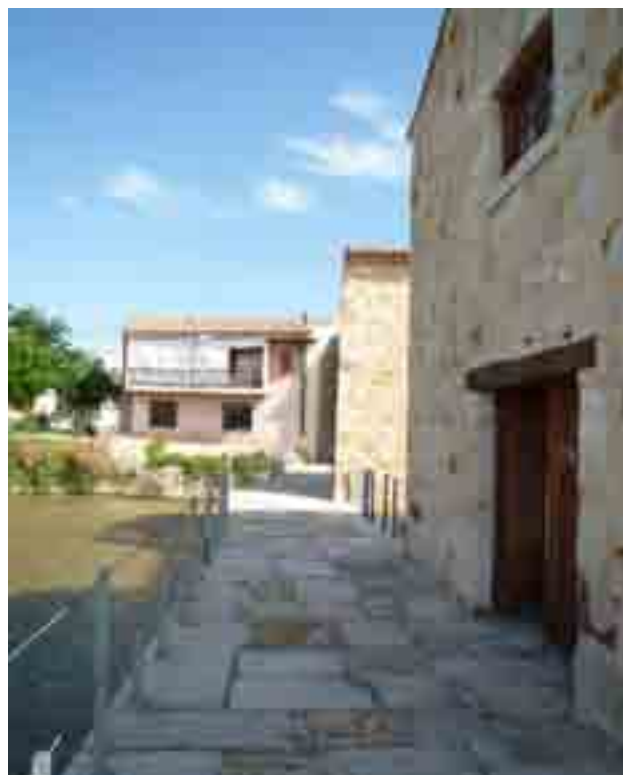
PUENTE DE UNIÓN ENTRE CUBOS ACEÑA DE OLIVARES.
