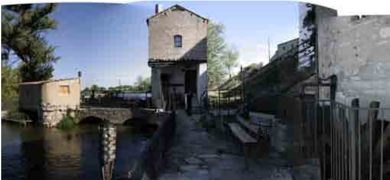
EXTERIOR DE LA ACEÑA DE LA PINILLA.
