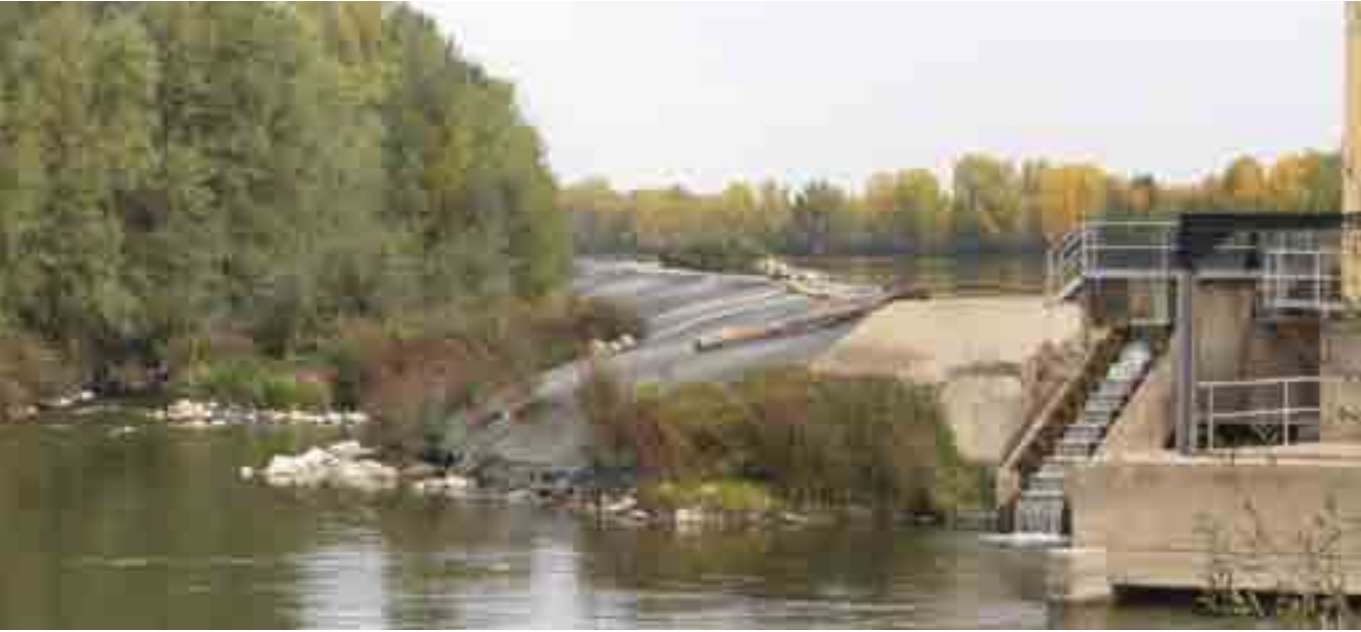
LA PESQUERA O AZUD DE LA MINICENTRAL SALVA UN DESNIVEL DE APROXIMADAMENTE TRES METROS DE ALTURA.
