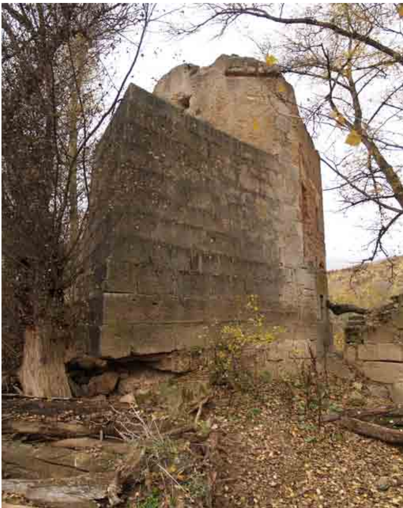
TAJAMAR DEL CUBO PRINCIPAL DE LA ACEÑA DE LA PERAL, EN TORO.
