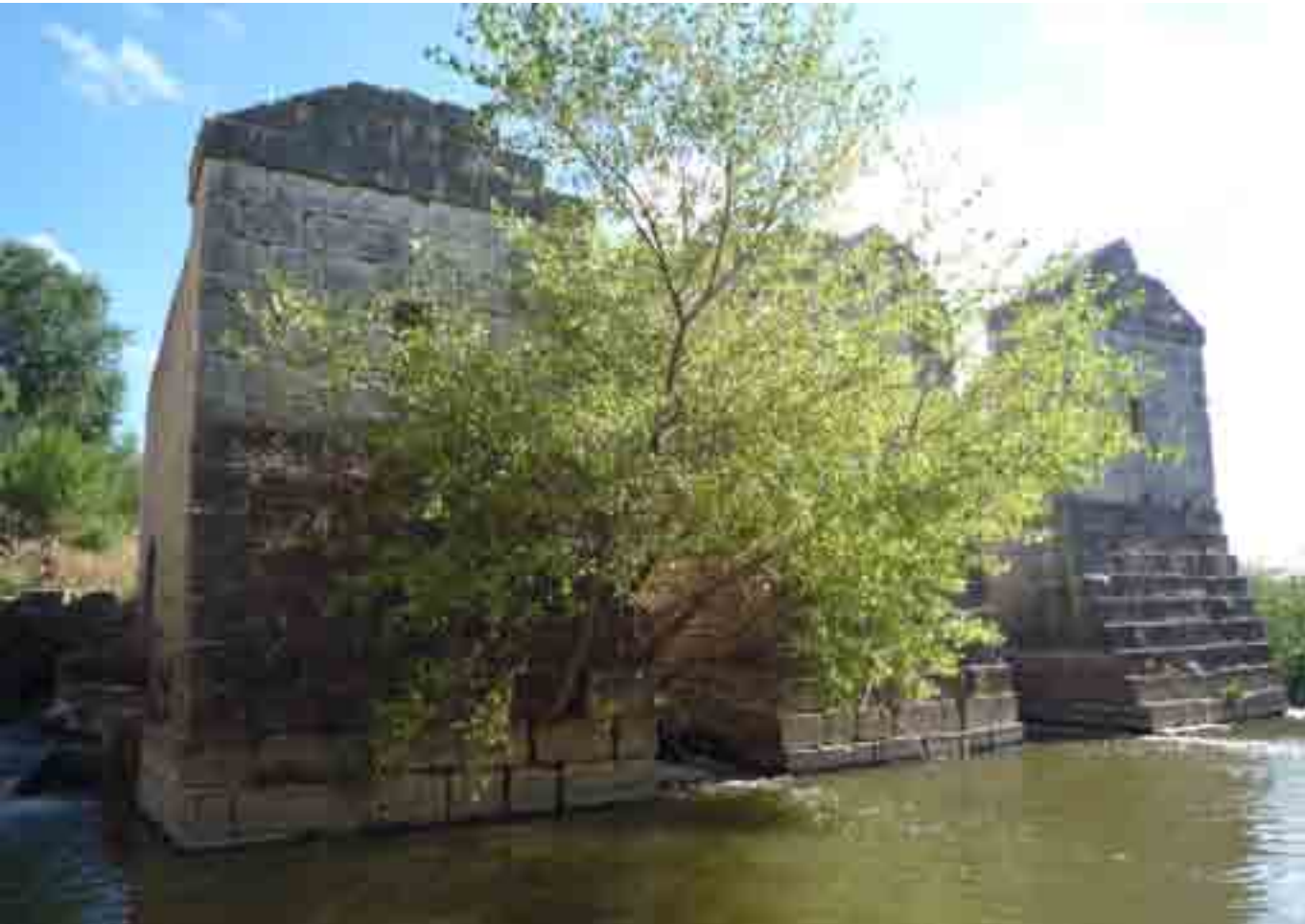
VISTA PANORÁMICA DE LOS ESPALDONES DE LA ACEÑA.
