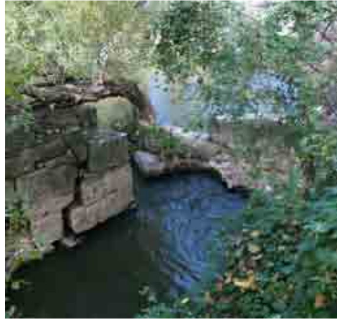
RESTOS DE LOS DESPRENDIMIENTOS DE LAS FACHADAS.
