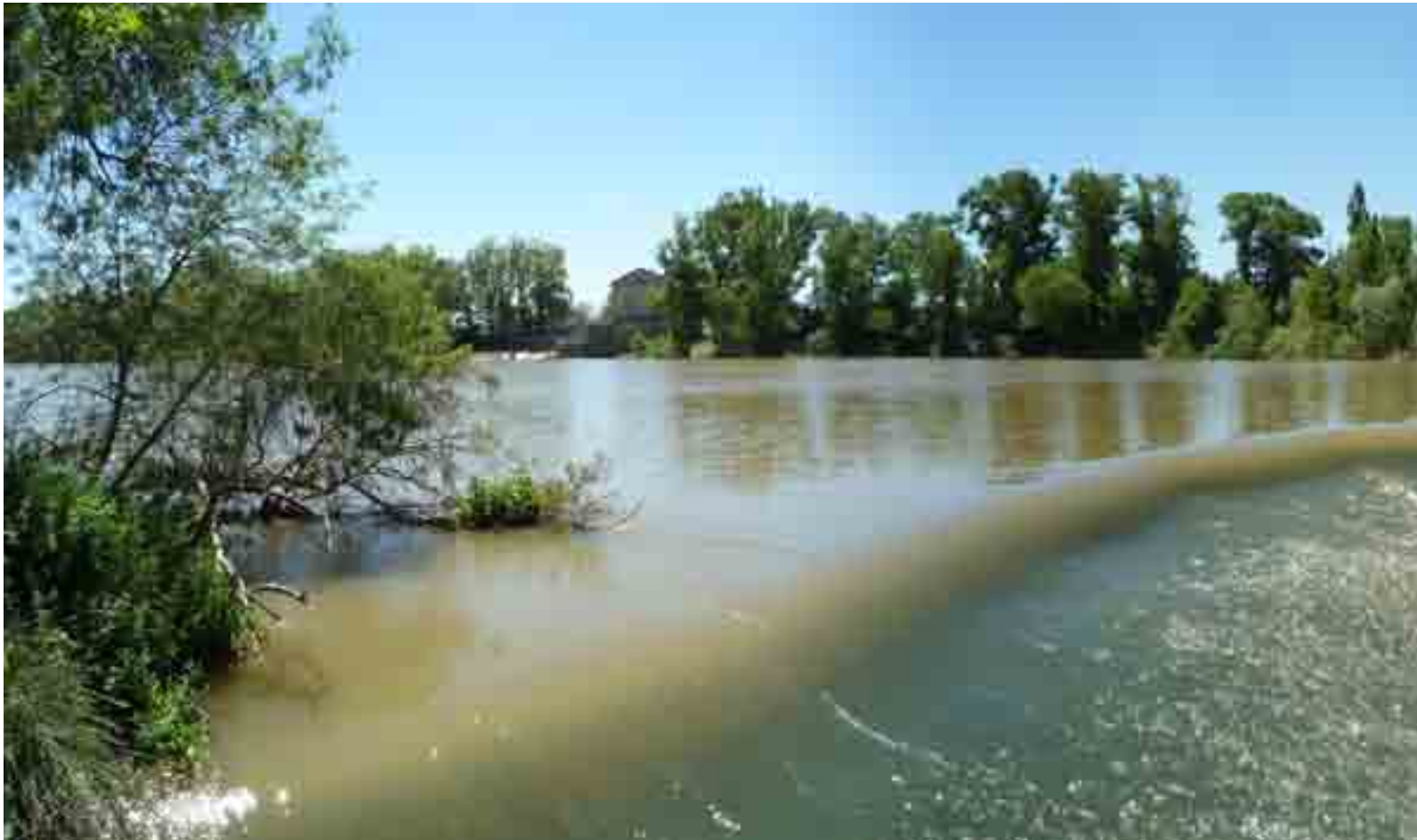
NUEVO AZUD DE LA MINICENTRAL ELÉCTRICA Y RESTOS DE LA ACEÑA DE SAN MIGUEL DEL PINO.
