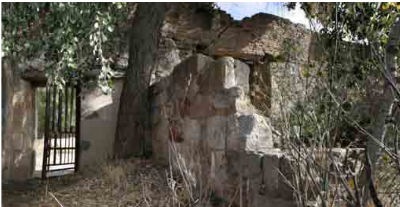
INTERIOR DEL CUBO DE ACCESO A LA ACEÑA.
