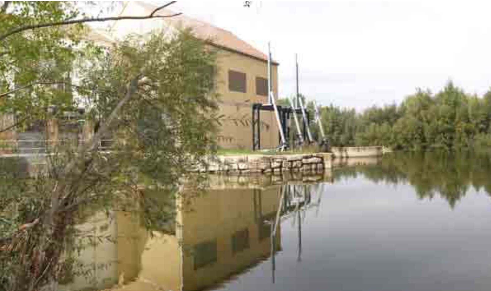
ENTORNO MINICENTRAL ELÉCTRICA DE LOS HERREROS, ZONA DE COMPUERTAS.
