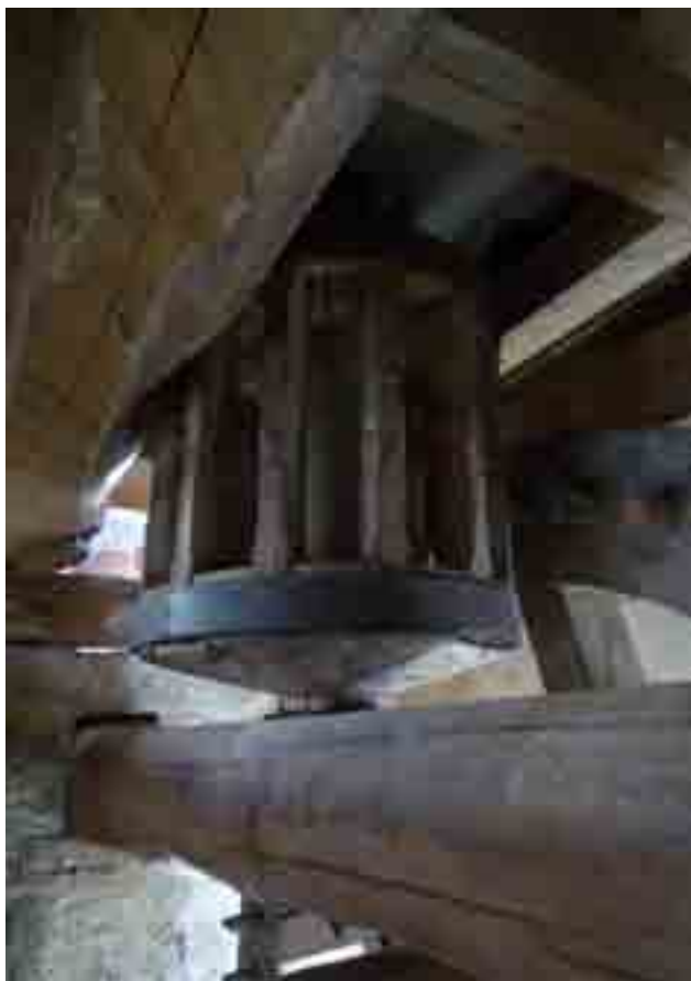
LINTERNA DE TRANSMISIÓN DEL MOVIMIENTO EN EL SISTEMA DE ENGRANAJES
