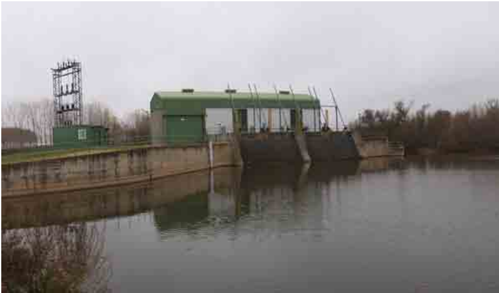
ENTORNO NATURAL MINICENTRAL ELÉCTRICA DE VILLARALBO, EN ZAMORA.
