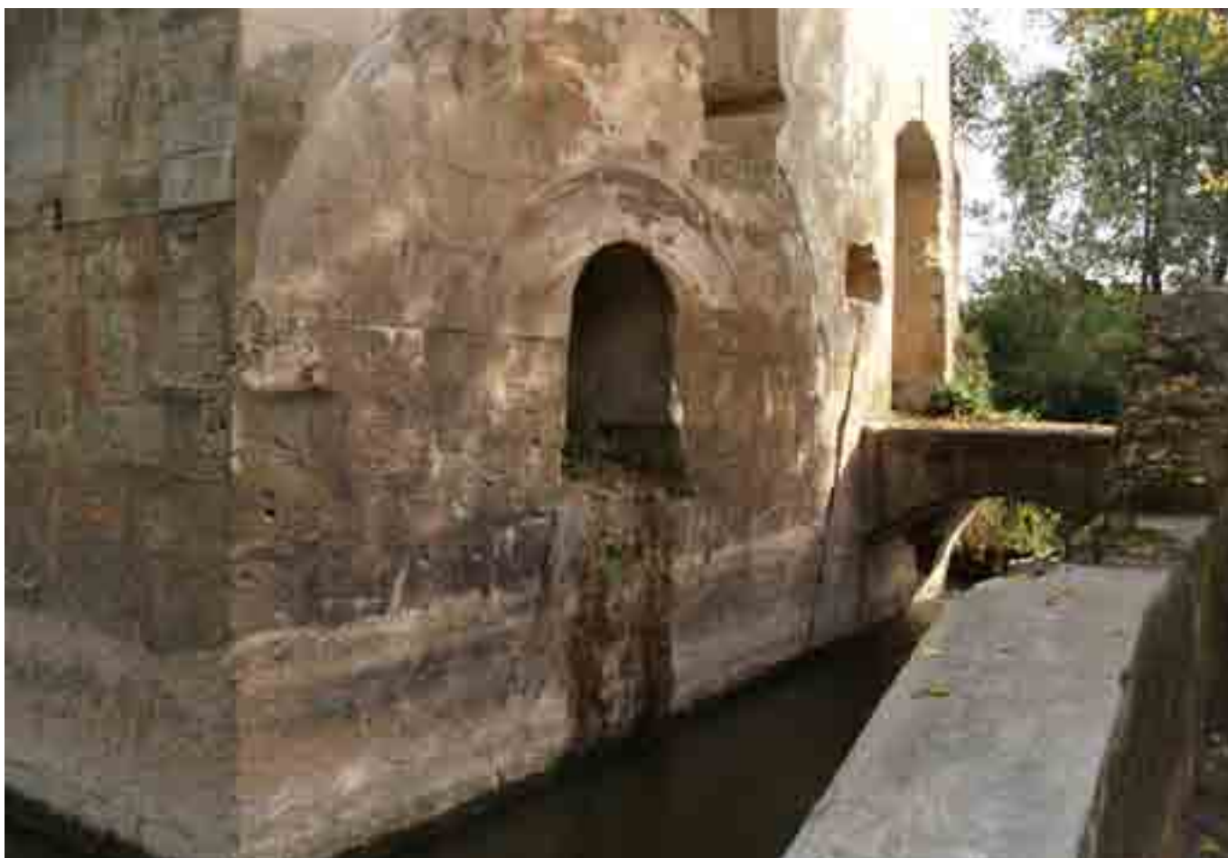
CANAL DONDE ESTABA LA RUEDA DE PALAS METÁLICAS.
