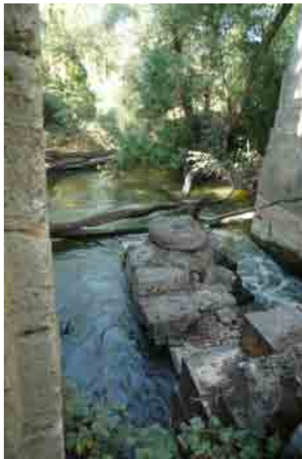
CUBO BAJO Y CANALES DE ENTRADA DE AGUA.
