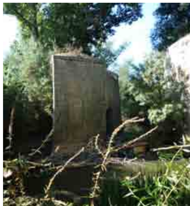
ACUMULACIÓN DE TRONCOS EN LOS CANALES.
