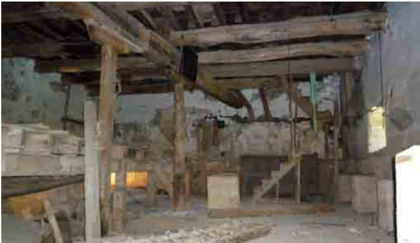
INTERIOR DEL CUBO PRINCIPAL DE LA ACEÑA, PLANTA BAJA.
