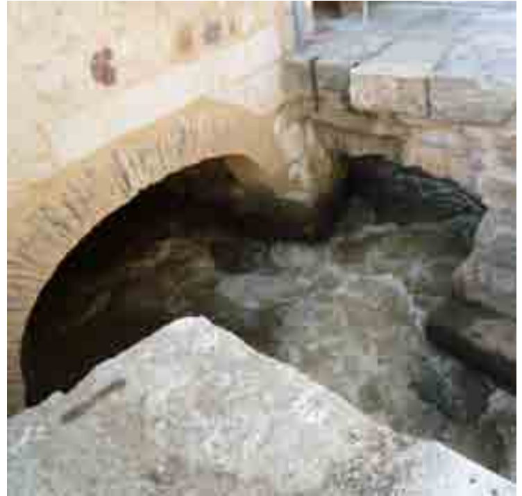
BOCA DE ENTRADA AL CÁRCAVO.
