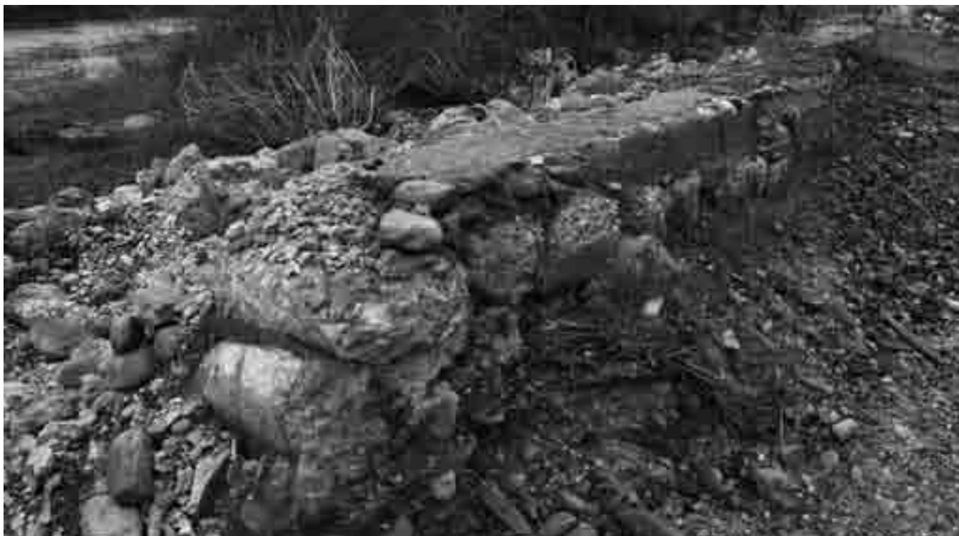
REPARACIÓN AZUD DE ACEÑA DEL VADO MEDIANTE SACOS RELLENOS DE HORMIGÓN.
