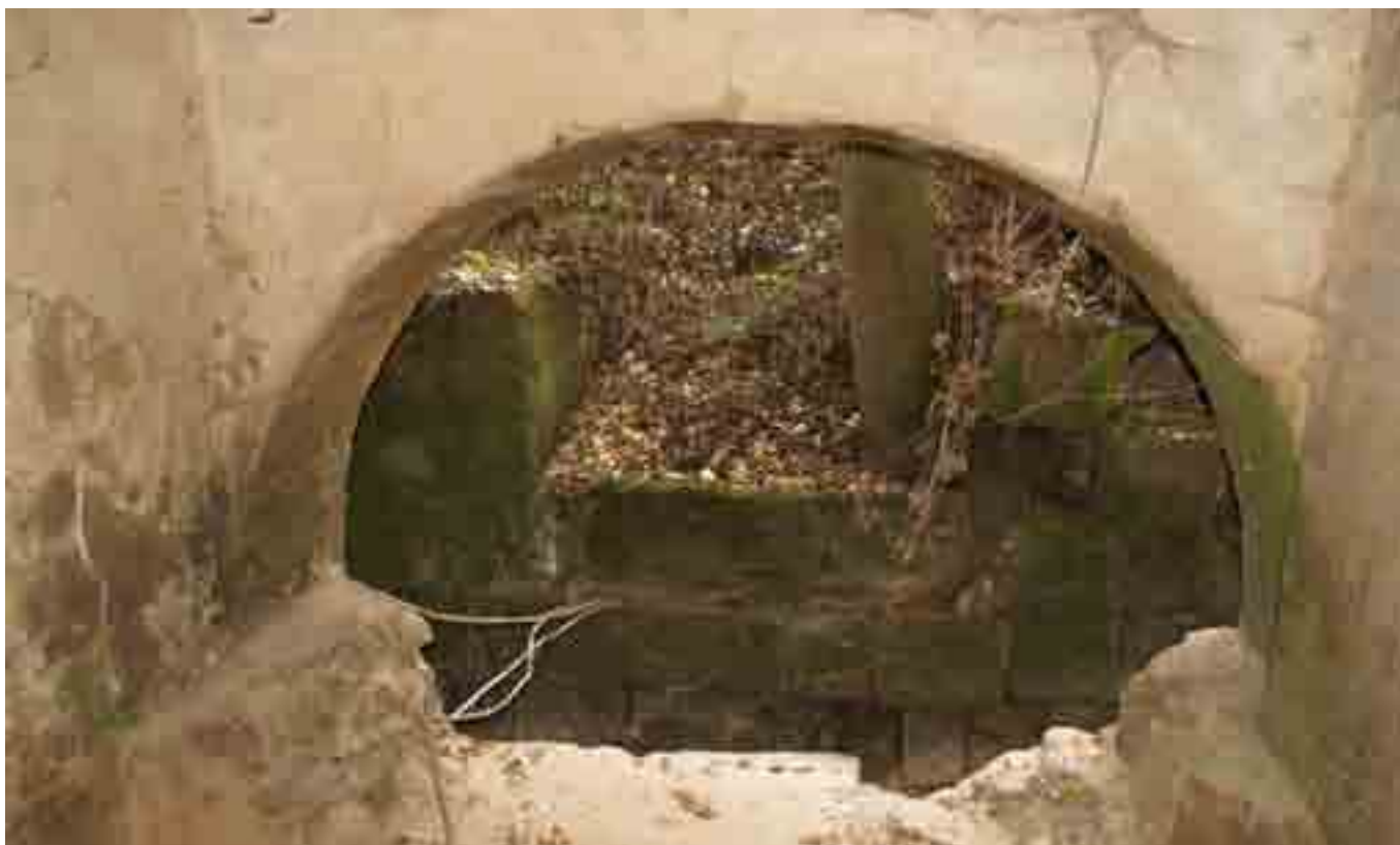
INTERIOR DEL CÁRCAVO.
