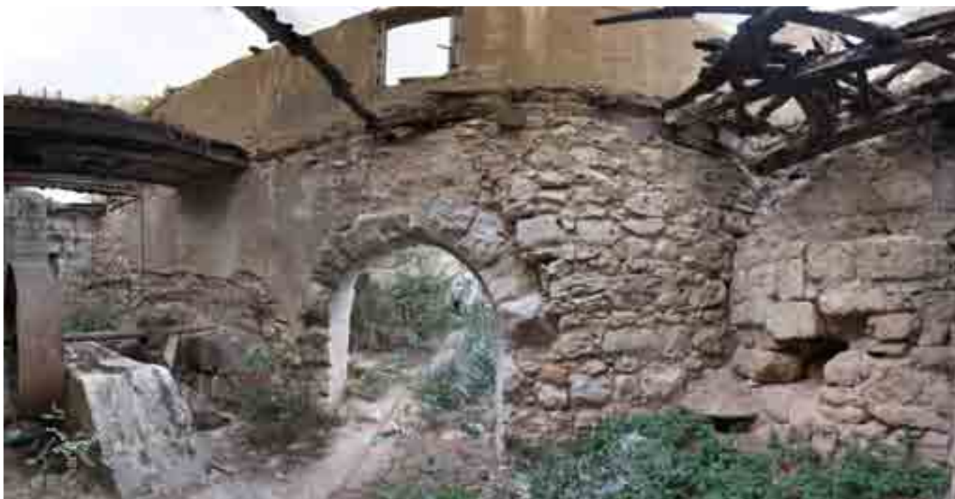
INTERIOR CUBO 1 ACEÑA DE ZAFRAGUILLAS, EN TORDESILLAS.
