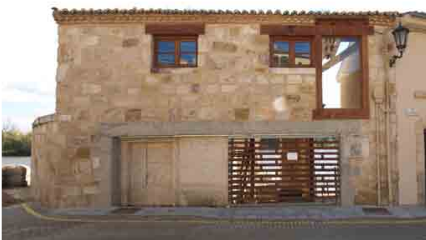
ACCESO A LA ACEÑA DE OLIVARES.
