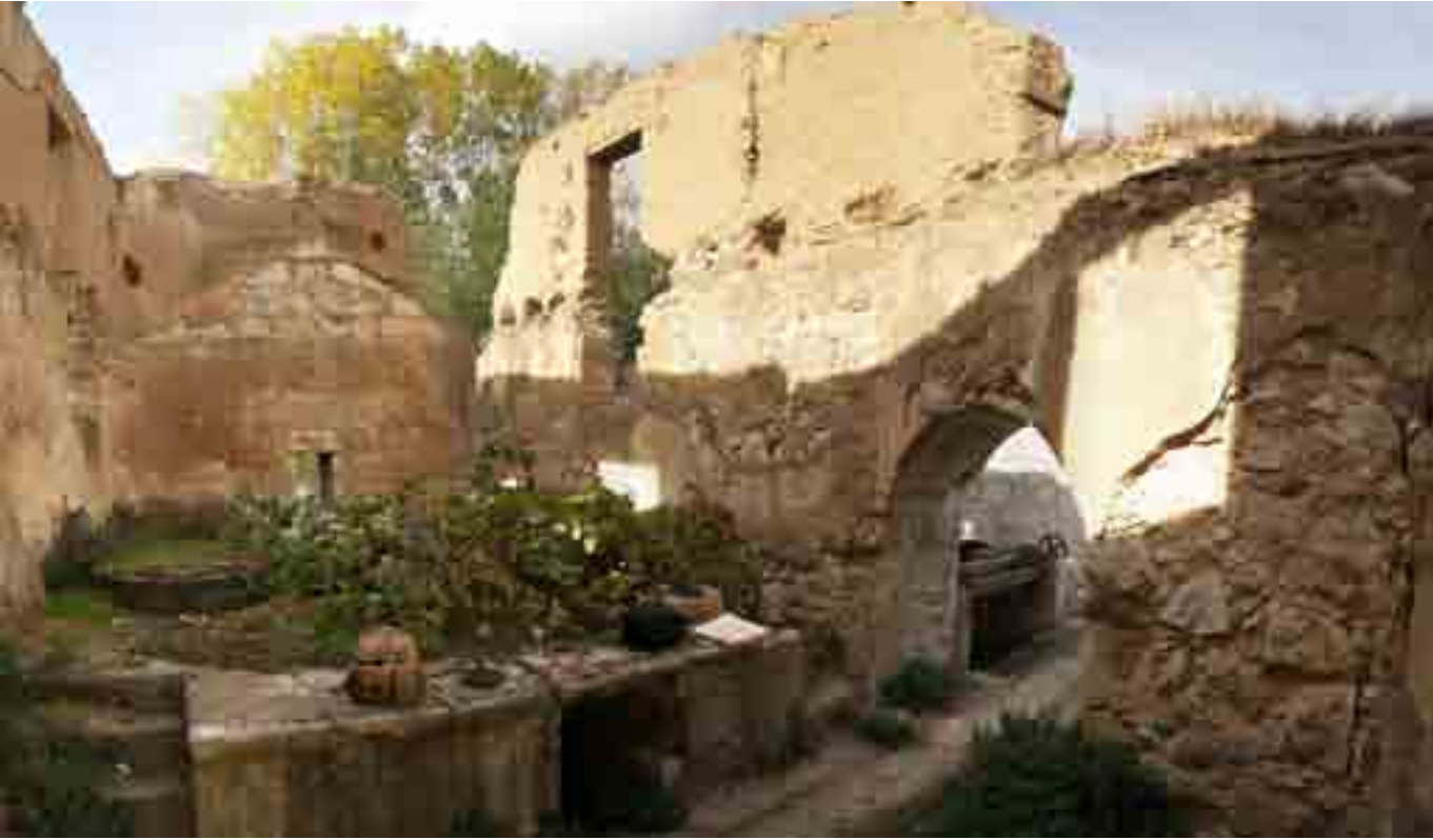
INTERIOR CUBO 2 ACEÑA DE ZAFRAGUILLAS, EN TORDESILLAS.
