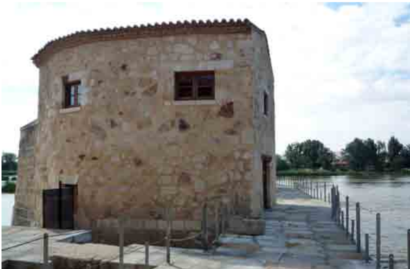
EXTERIOR CUBO 2 DE LA ACEÑA DE OLIVARES, EN ZAMORA.
