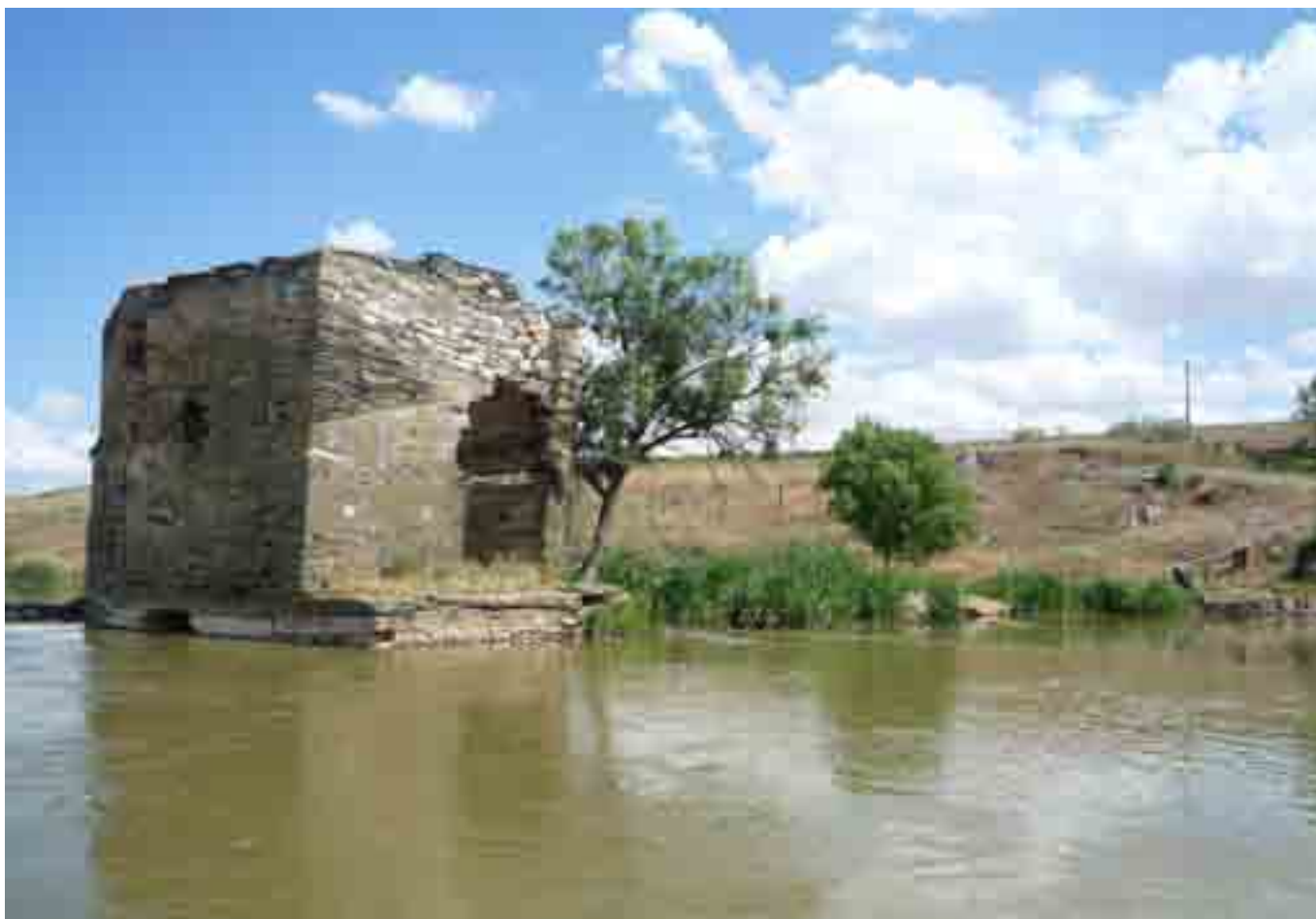
EXTERIOR DEL CUBO DE LA ACEÑA DE CONGOSTA.
