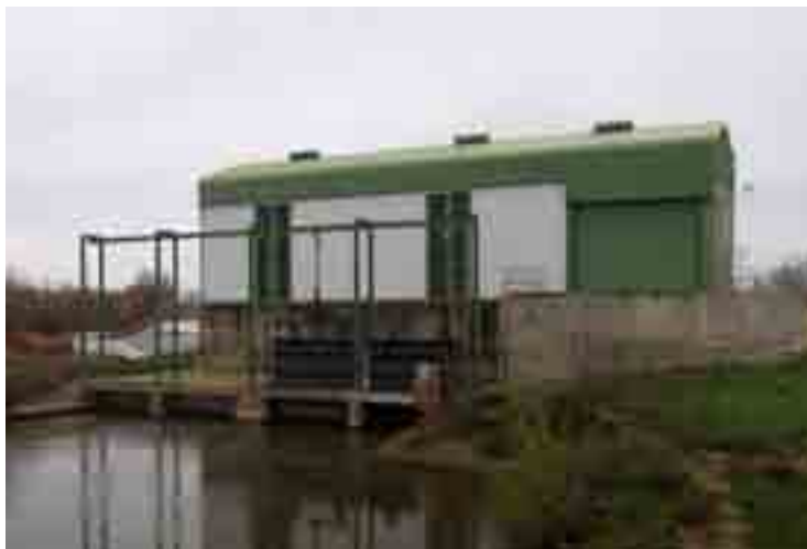
COMPUERTAS DE CANALES DE SALIDA DE LA SALA DE TURBINAS.
