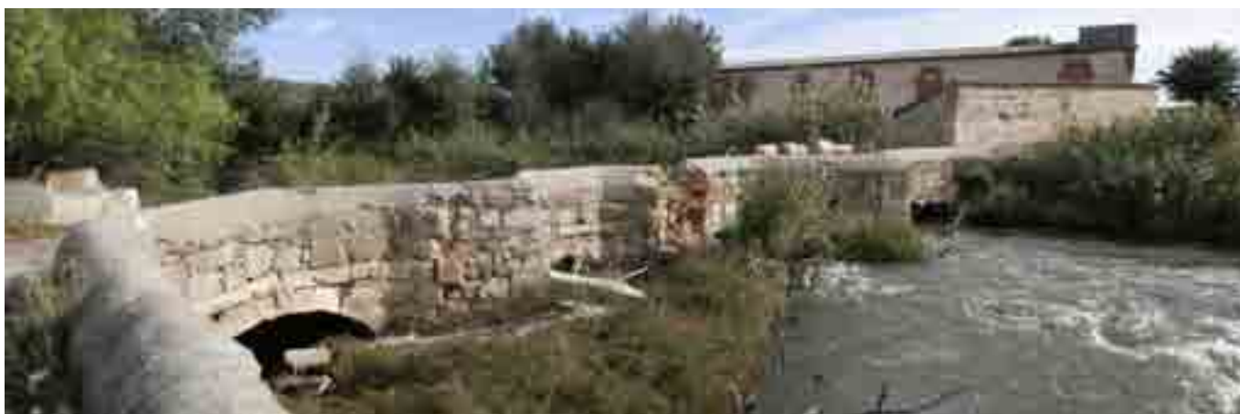
EL ACCESO A LA ACEÑA SE REALIZA A TRAVÉS DE UN PUENTE DE PIEDRA.
