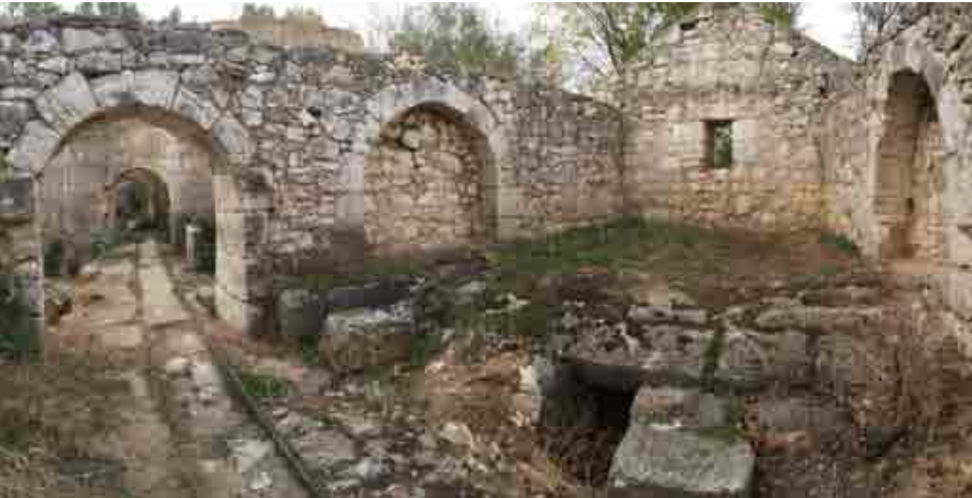
INTERIOR DEL CUBO 3.
