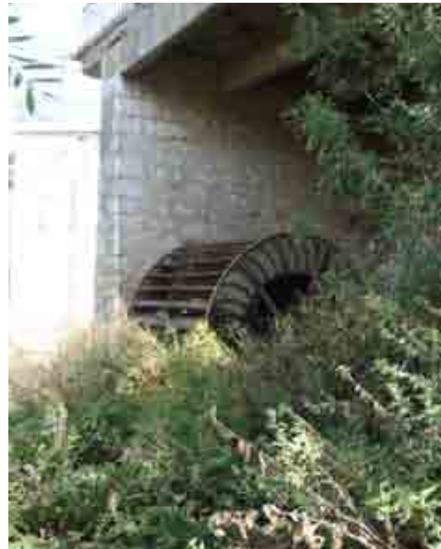
RUEDA DE PALAS DE ACEÑA DEL PUENTE.
