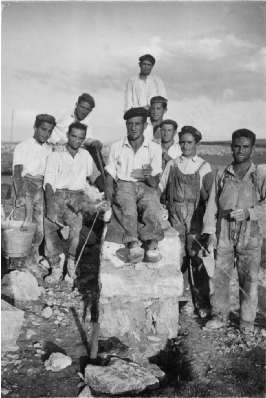
Obreros de San Pedro de Gaillos y pueblos de la comarca, década de los 40 del siglo XX
